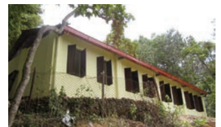
完成した1棟2教室の校舎
