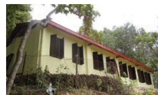
完成した1棟2教室の校舎
